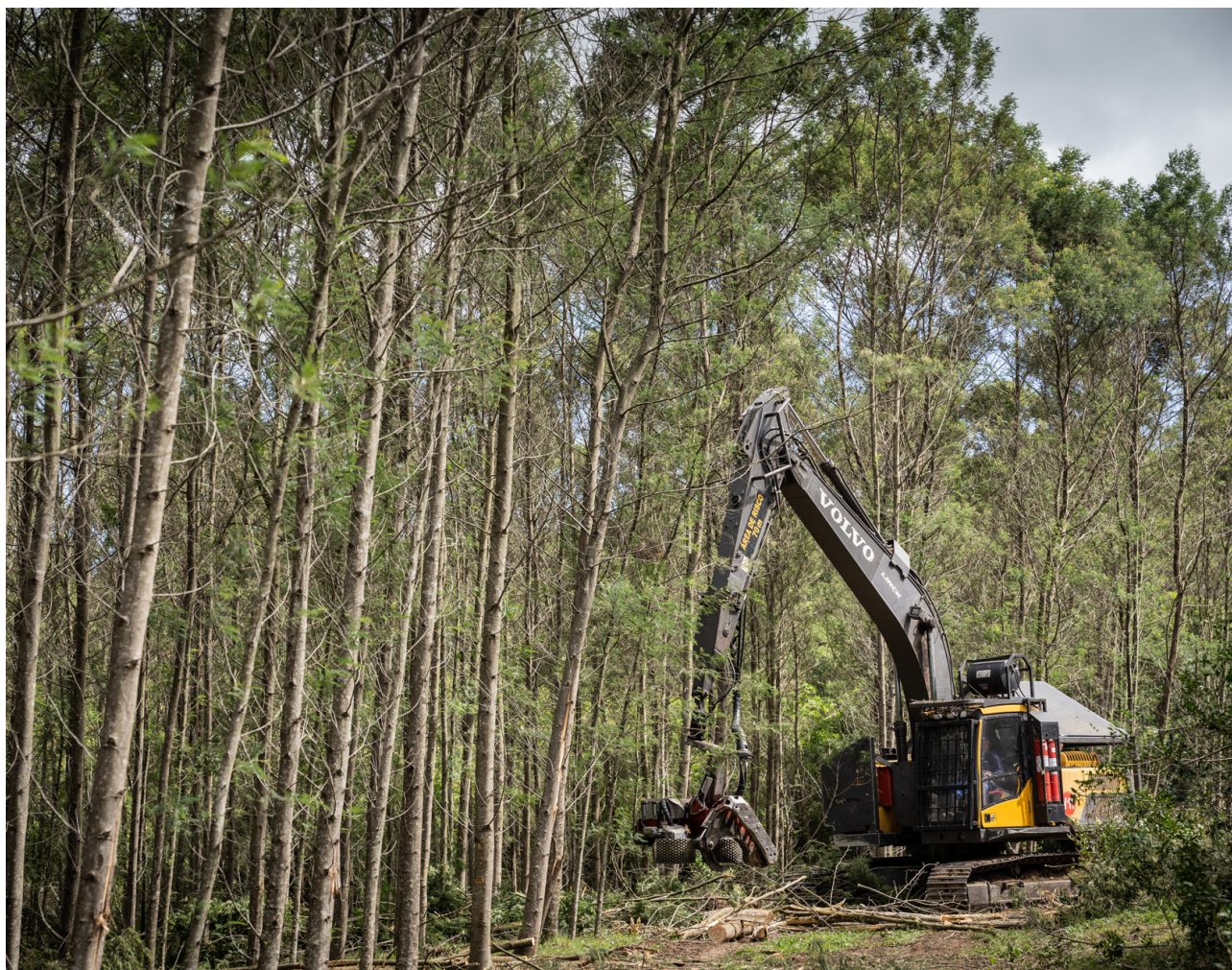
Derrubada e desgalha manual
